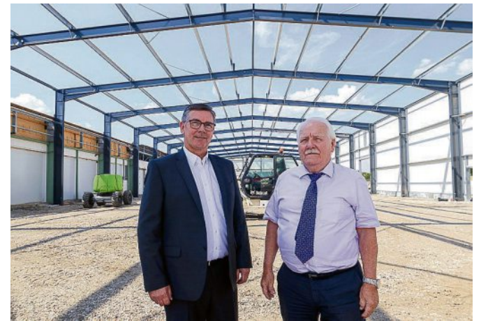
Patrick (l.) und Heinz Dieter Bauer in der neuen Halle, die klimafreundlich und energiearm gebaut wird. Das Südlohrer Unternehmen investiert fünf Millionen Euro und stellt weiter neues Personal ein.
